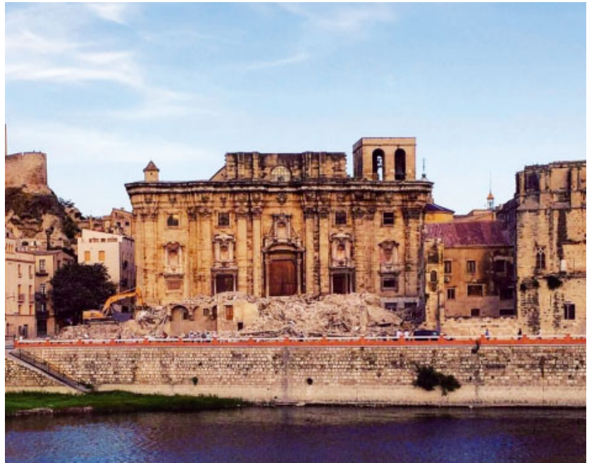
Nova imatge de la façana de la Catedral després de l'inici de les obres d'enderroc de les cases que hi havia al davant
